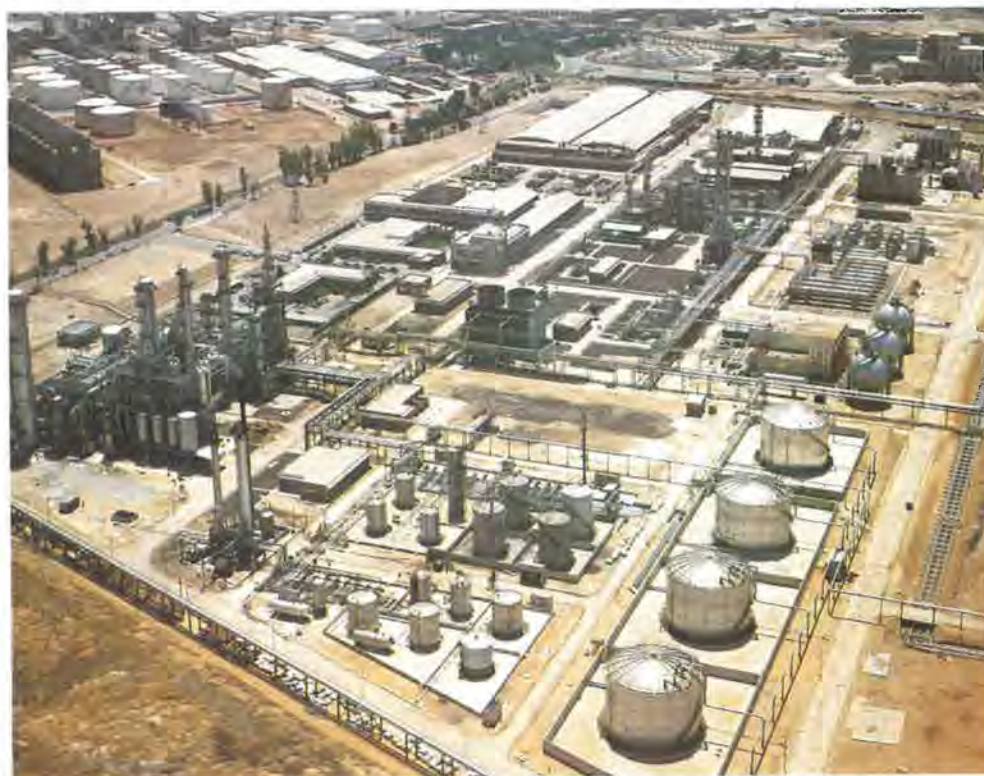
Complejo petroquímico de Puertollano (Ciudad Real).
