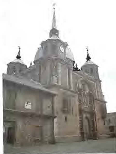
Iglesia barroca de San Carlos del Valle (Ciudad Real).
